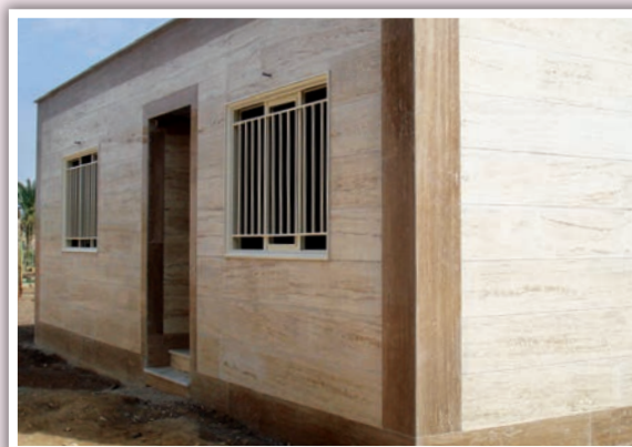
ساختمان اداری و آزمایشگاهی
