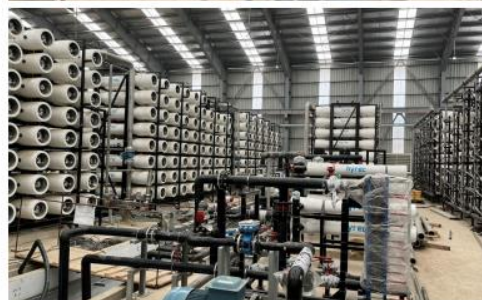
شکل ۳۲- مراحل ساخت و نصب واحدهای مختلف غشایی پروژه تولید نمک گرید غذایی از آب دریا در اندونزی [۱۰۸]
